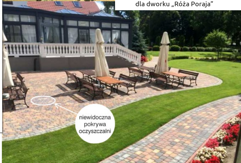
Oczyszczalnia zainstalowana dla dworku „Róża Poraja”
